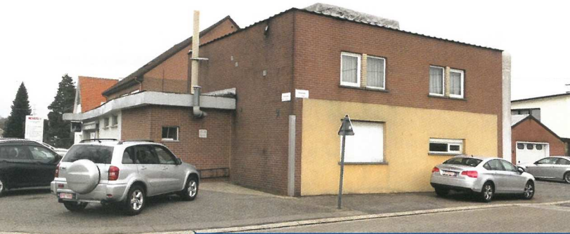
[18] Diesen 25 km von Maasmechelen entfernten Standort, mit einem kleinen in die Jahre gekommenen Laden, wollte Fastré erst nur renovieren. [19] Dann entschied er sich das Gebäude abzureißen und dort ein modernes Fachgeschäft zu errichten. Seitdem verzeichnet der Standort steigende Umsätze.
