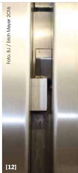
[9] Die Ofentür ist mit einem innenliegenden Mechanismus ausgestattet, der sie mit dem Herunterdrücken dieses Handhebels mit wenig Kraftaufwand komplett anhebt. [10-11] Sowohl an der Schlosssäule als auch am Türblatt befinden sich oben und unten jeweils zwei solcher justierbarer Keilpaare aus massivem Edelstahl. [12] Diese greifen beim Schließen und Absenken der Tür ineinander und pressen sie fest an die Dichtfläche, sodass nahezu kein Dampf mehr aus der Backkammer entweicht.
