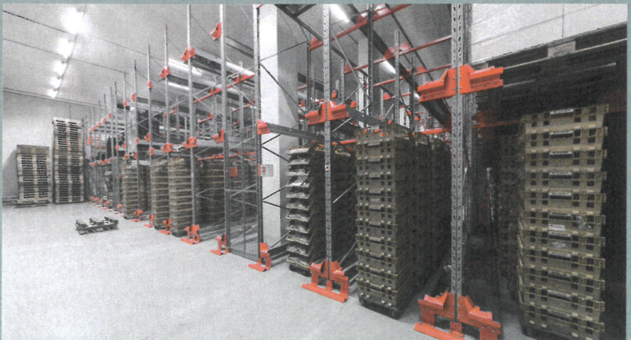
In de vriezer is ruimte voor 3.000 pallets.
