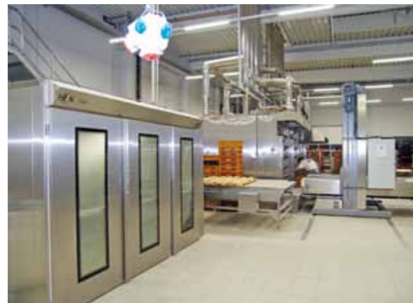
HEIN lieferte neben der Ofenanlage mit zwei UNIVERSAL Ringrohrretagenöfen mit halb-automatischem Beladeroboter SPIDER und zwei ECOSTONE2 Stikkenbacköfen auch den Gärraum. Der ist leicht demontierbar, so dass bei Bedarf noch ein weiterer Etagenofen Platz hätte.
