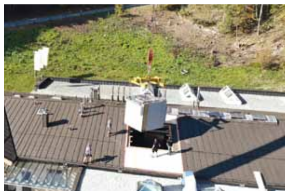
Dach auf, Ofen rein: Mit einem Autokran kam der neue Ringrohretagenofen in die Backstube.
